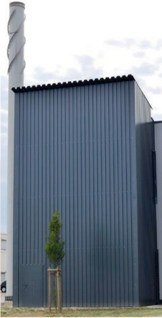
Abb. 28: Außenlager (70 t), bestehend aus zwei Gewebesilos mit Einhausung
