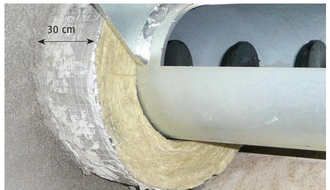
Abb. 35: Detailansicht einer Wanddurchführung. Bei Schnecken in Stahlrohren bei Querung von Brandwänden die Mineralwolle links und rechts 30 cm überstehen lassen. Bei Kunststoffrohren ist bei Querung von Brandwänden eine Brandschutzmanschette erforderlich.
